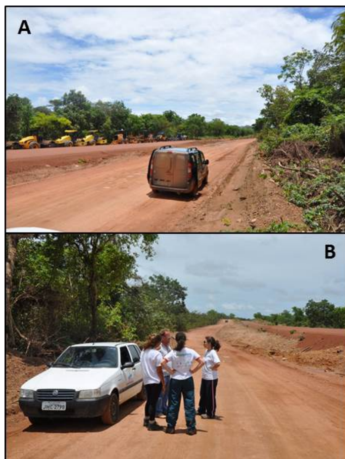
Figura 8. Remoção da vegetação para a pavimentação das estradas. A = Tratores estacionados no canteiro de obra. B = Equipe CNCFlora conversando com engenheiro civil responsável pela obra.
