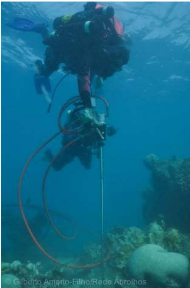
**Figura 20** – Operação inédita com o *drill* hidráulico submarino, recém adquirido pela Rede Abrolhos. Com esse equipamento, foi possível obter testemunhos profundos dos recifes de Abrolhos, permitindo que sejam realizadas análises geológicas pioneiras no Brasil.
